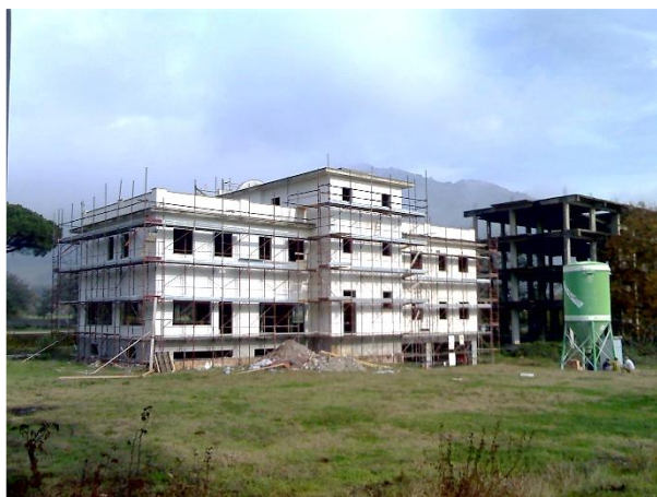
Foto a lavori in corso
