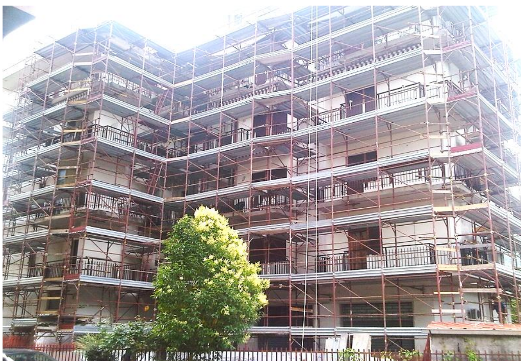
Di fianco sinistro foto particolare dei lavori in corso
