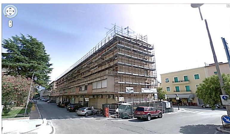
Foto lavori in corso
