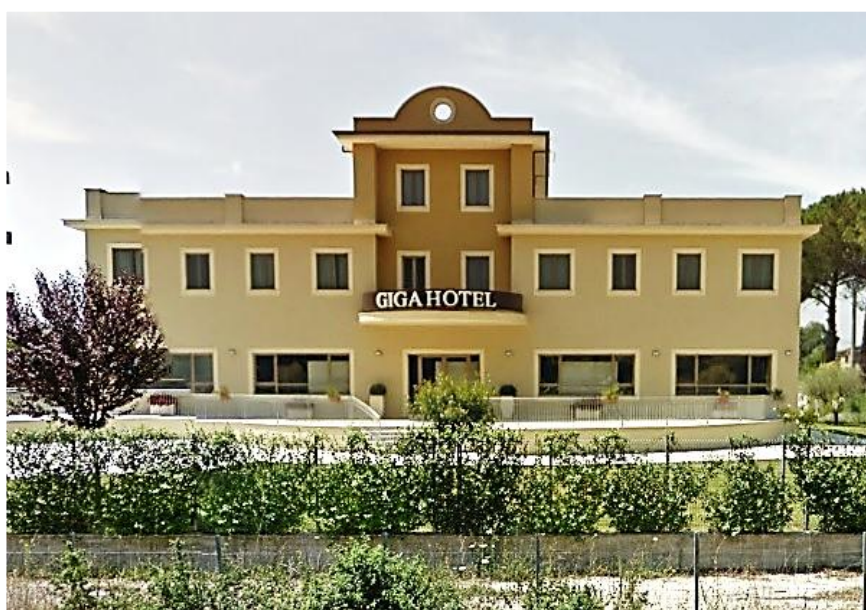
Foto a fine lavori
