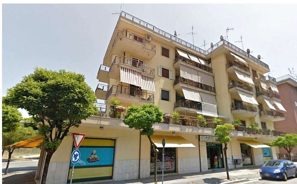
Di fianco destro foto particolare a fine lavori
